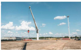
4- Puerto de Posadas
